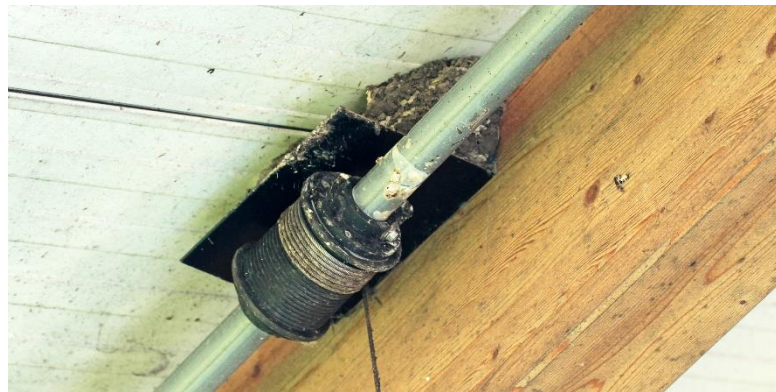
Plankjes moeten vervuiling van katrollen en stangen van windschermen voorkomen
